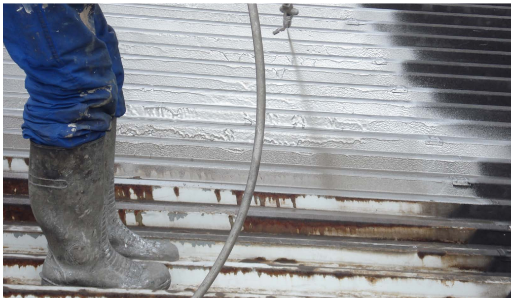
Esthetisch spuiten is geen noodzaak. Een dikke laag is voldoende. Sowieso vloeit de dikke laag nog redelijk egaal uit
