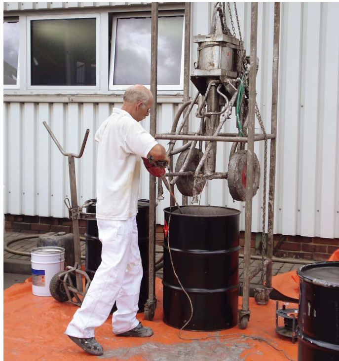
De pomp hangt in een frame aan een takel. Zo is de bitumen te mengen. Door de pomp te laten zakken, zakt ook de aanvoerbuis diep in de bitumen
